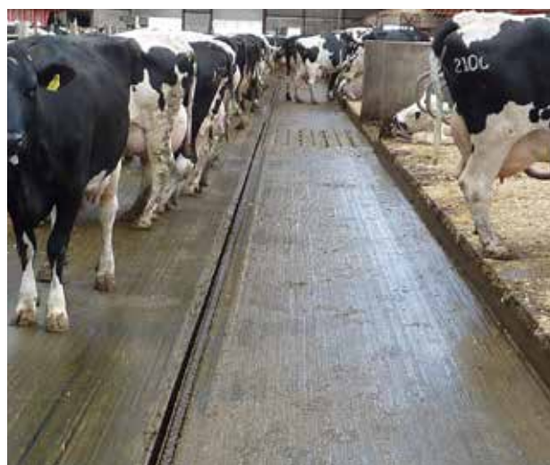
Figur 18. Gulvet er eftermonteret med flere skruer ved foderbordet så det ikke skubbes ud over rillen til skraberwiren/-kæden
