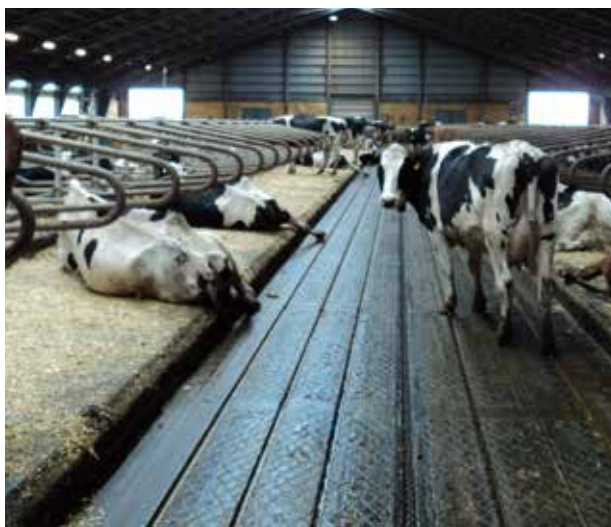
Figur 14. Gummi mod gummi giver ren og tør overflade
