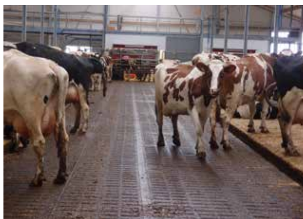
Figur 10. Eco-floor fra HZ Skibelund, en kombination af beton og gummi der let rengøres med robotskraber.
