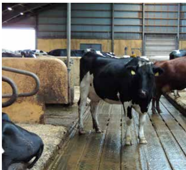
Figur 6. Rene klovs på Perstrups præfabrikerede gulv med afleveringsåbninger
